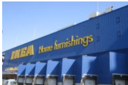
都市軸沿道 イケア・ジャパン 株式会社建設事業 H26年オープン 予定
