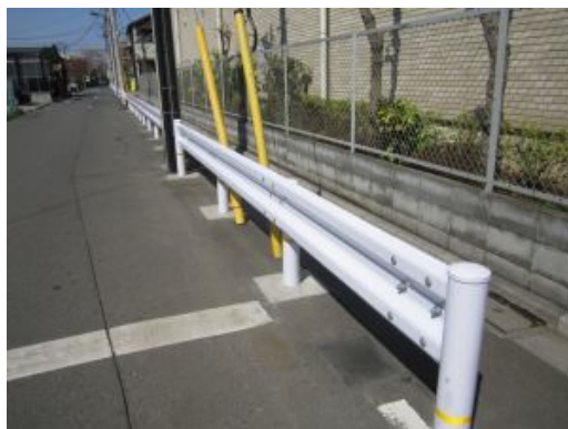
柏町三丁目のガードレール
